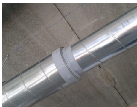
Figure 1 : Raccordement correct du réseau
