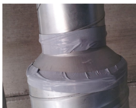
Figure 2 : Raccordement non correct du réseau
